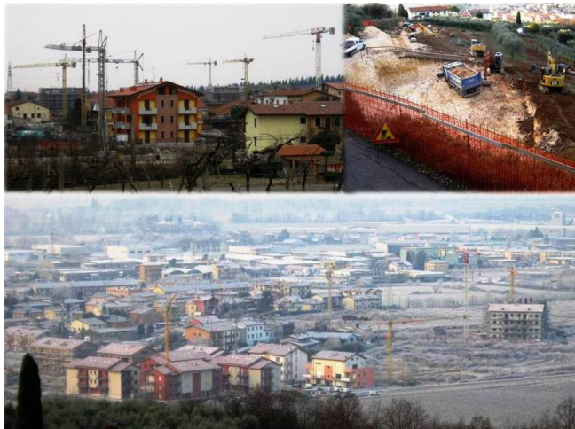
Figura 3. Le foto (di Luca Simone Rizzo, 2011 e 2012) ritraggono un esempio dei vari cantieri ancora aperti in San Martino Buon Albergo (comune veronese dove il fenomeno di consumo e conversione di suolo ha subito un'accelerazione e assunto connotati – quasi – allarmanti negli ultimi tre anni; fatto che non emerge dal dato regionale più recente, quello al 2009).
